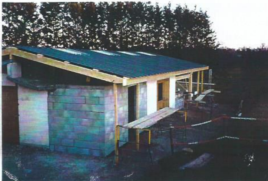
Les vestiaires en cours de travaux.....
