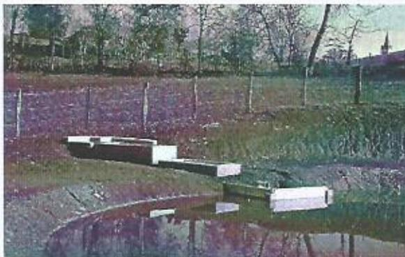
Système de déversoir permettant l'écoulement abondant des eaux de pluie lors d'orages, en dehors de la première lagune.
