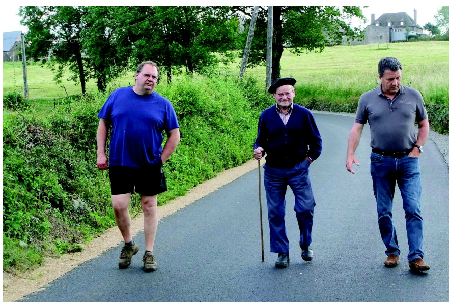
Visite de chantier de la voirie de Contres Jean-Marc Delbos, Abel Picaronny, M.Lafarge (Entreprise CROUTE)
